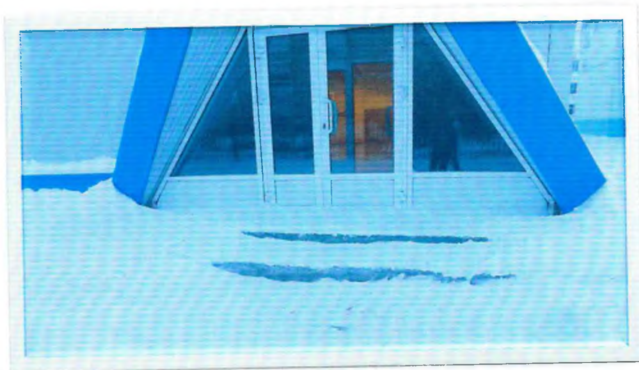
Фото 22 Путь эвакуации – запасной выход из спортивного комплекса № 3
