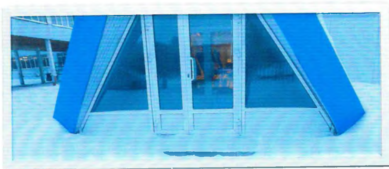
Фото 23 Путь эвакуации – запасной выход из спортивного комплекса № 3
