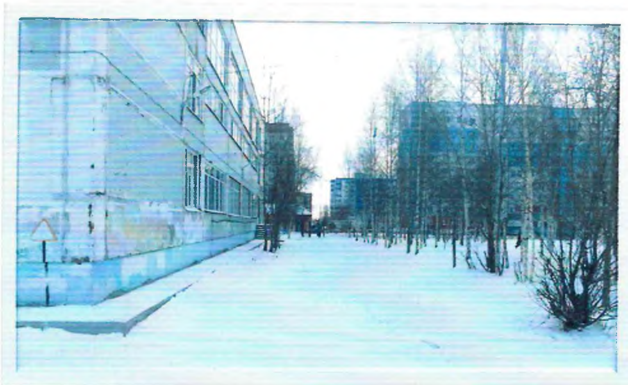
Фото № 10 Проход по территории к центральному входу
