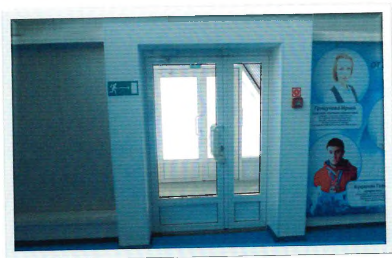
Фото № 10 Путь эвакуации из спортивного зала
