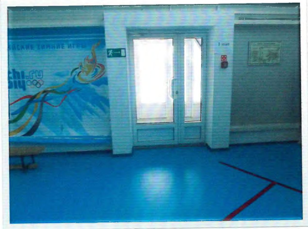
Фото № 8 Дверь правая запасного выхода из спортивного зала
