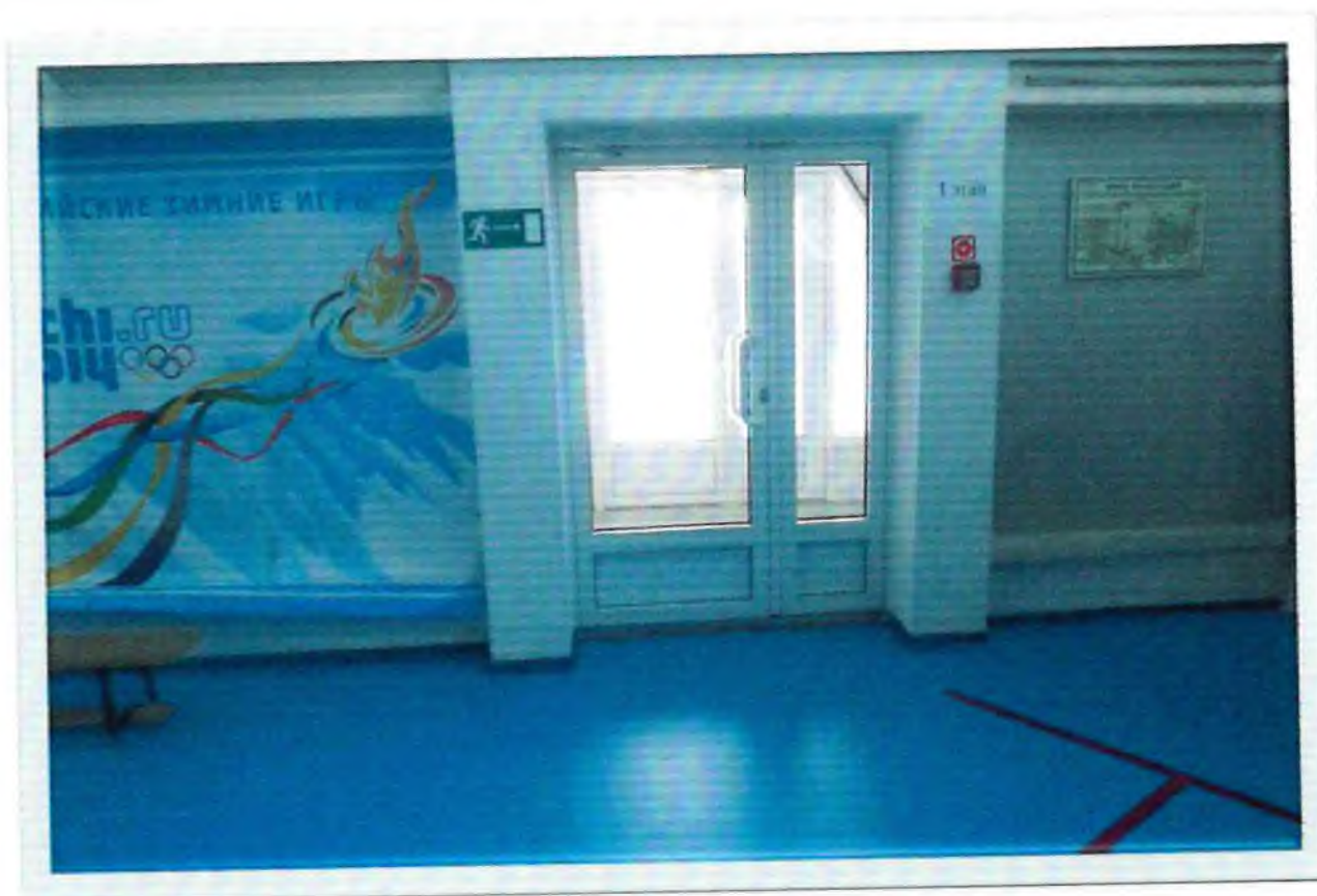
Фото № 11 Путь эвакуации из спортивного зала
