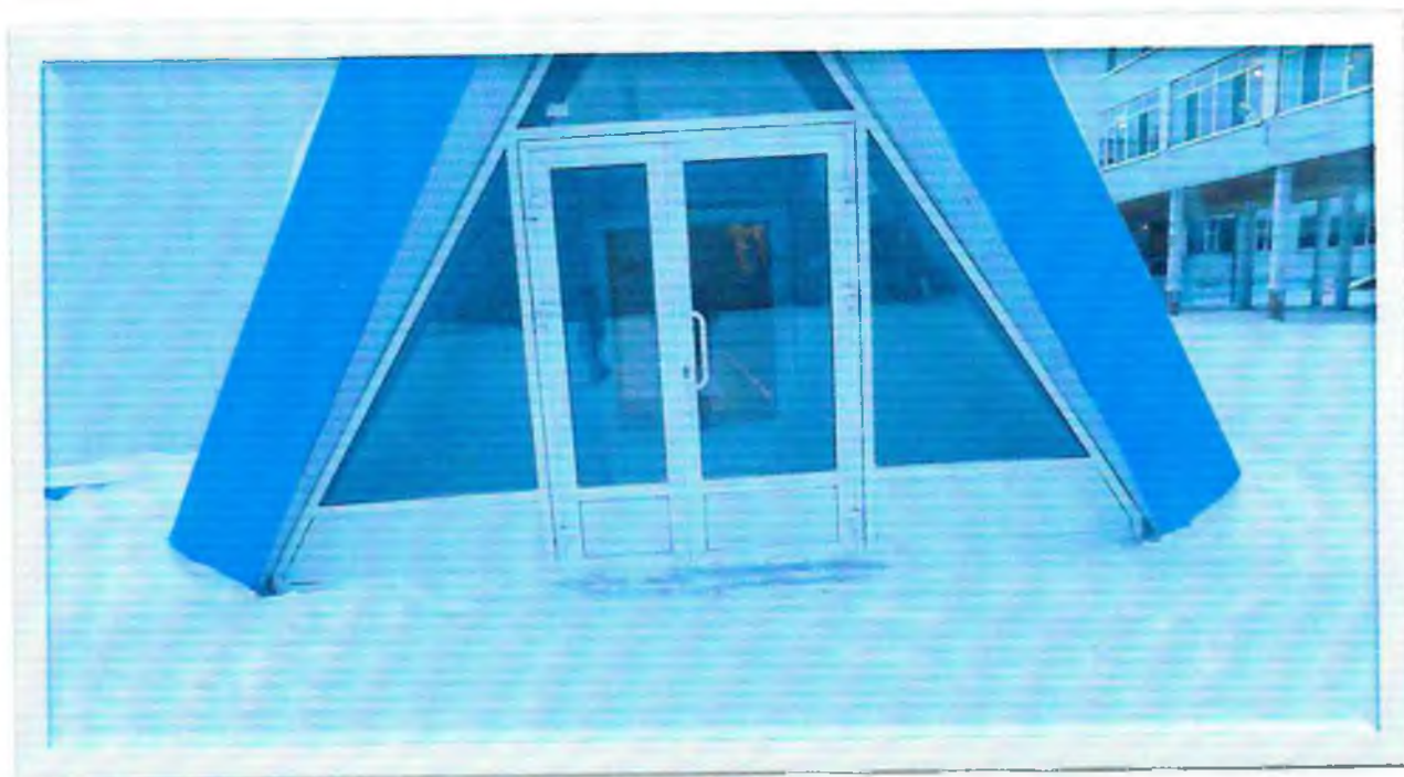
Фото 24 Путь эвакуации – запасной выход из спортивного комплекса № 3
